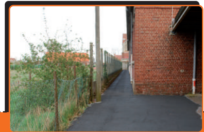
Un nouveau revêtement a été posé dans la ruelle de l'école César Dewasmes.
