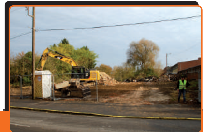
La ferme, située à côté de l'école César Dewasmes, a été abattue par l'Etablissement Public Foncier dans le cadre de l'opération « Cœur de Ville ».
