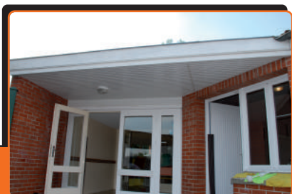
Le sas d'entrée extérieur de l'école maternelle au No à Houx a été rénové.
