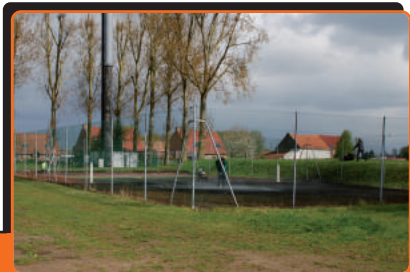
Des travaux de réfection du terrain de tennis ont été menés avec un bon nettoyage et la réparation de la clôture.
