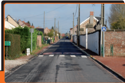
Les travaux de réfection de voirie ont été effectués dans la rue de l'Egalité, rue Molière et rue Mirabeau.
