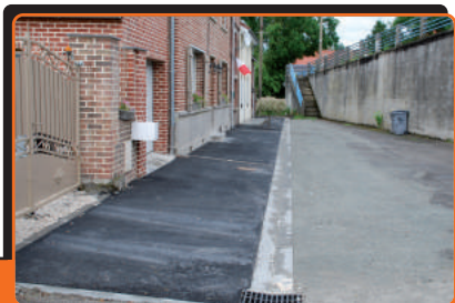
Les travaux de pose de bordures sont achevés dans le rue Chanzy, rue de l'Egalité et Place Jean Bart.
